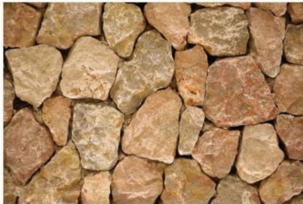
Eine über zehn Meter hohe Steinwand, errichtet im Stil von Trockensteinmauern, verbindet die Untergeschosse.
